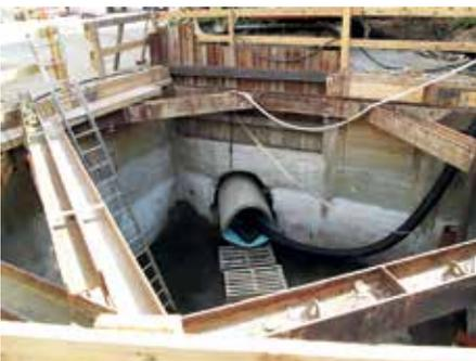
Mit diesem GFK-Haubenprofil wurde eine Teilstrecke des Sammlersystems „Cannstatter Straße“ saniert.
