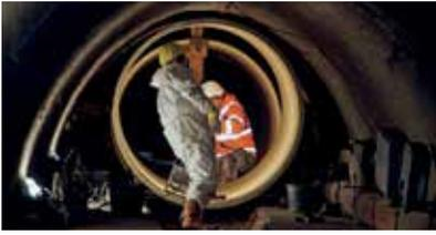
... in das Haubenprofil eingeschoben und schließlich an den bereits liegenden Rohrstrang angekoppelt. Foto: AMIANTIT
