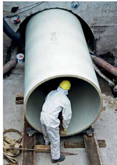
Die 1,5 Tonnen schweren Rohre wurden auf einen speziell für dieses Bauwerk konstruierten Einfahrwagen aufgesetzt ...
