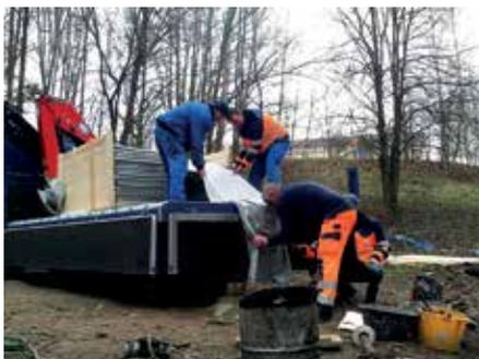
Einziehen des 210 Meter langen, mit photoreaktivem Kunstharz getränkten GFK-Liners.
