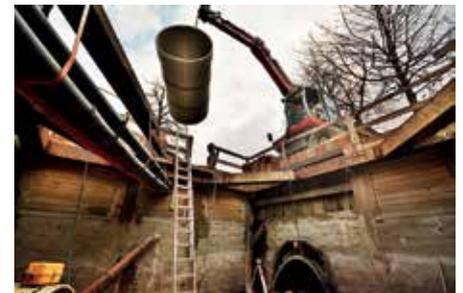
Einheben eines 3 Meter langen GFK-Kurzrohrs in die Montage-Baugrube auf dem Gelände der Polizeiwache Mettingen.
