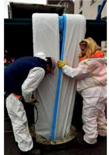
GFK-Schlauchliner großer Nennweite beim Einzug in den Untergrund.
