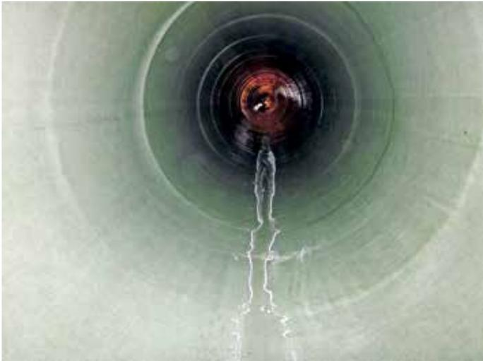
Alte Kanäle fit für weitere Jahrzehnte: betriebsbereiter GFK-Schlauchliner.
