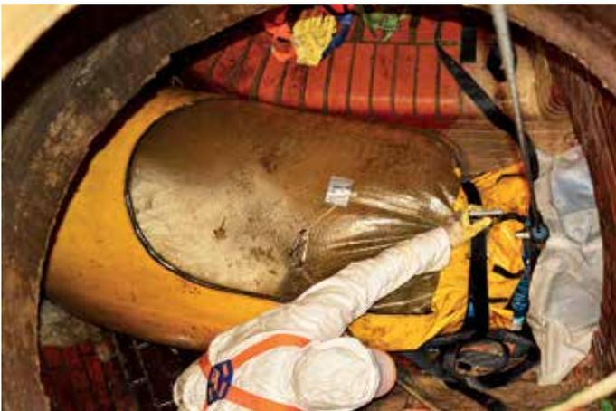
Begehbare Druckschleuse eines großkalibrigen Schlauchliners. In der Schleuse kann ein Mitarbeiter den UV-Lampen-Zug starkklar machen, ohne dass dabei der Luftdruck im Liner abfällt.
