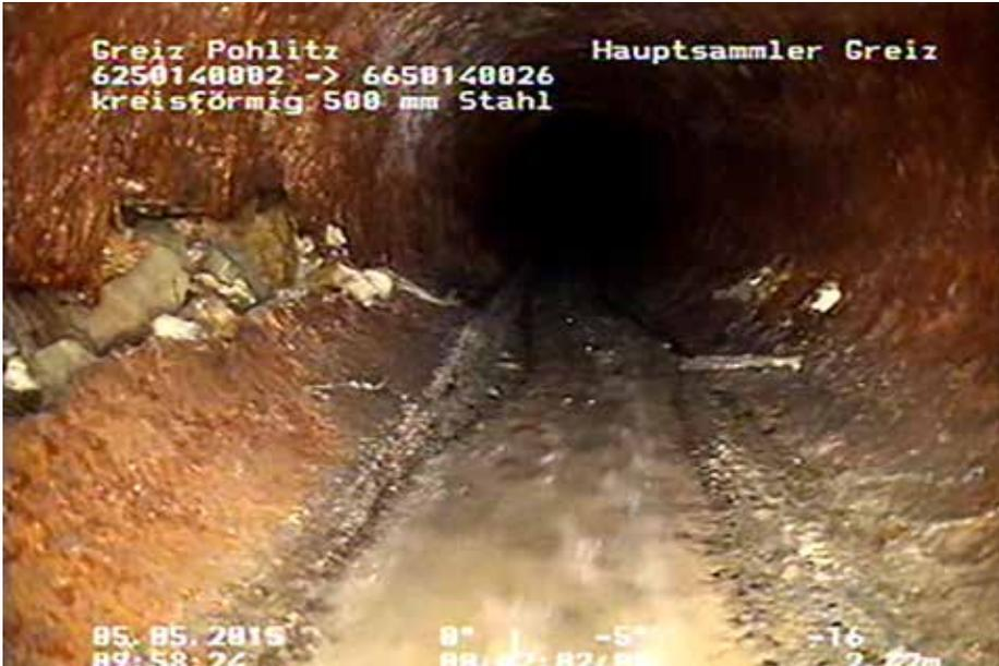
Tiefgreifend korrodiert: Das Stahlrohr war ein unabweisbar dringender Sanierungsfall.
