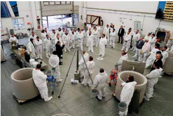
Selbstständig händisch applizieren durften die Teilnehmer beim zweitägigen Anwenderlehrgang im Trainings- und Seminarzentrum der MC in Bottrop verschiedene Mörtelsysteme bei der Reprofilierung und Beschichtung von Schächten. Foto: MC-Bauchemie, Bottrop
