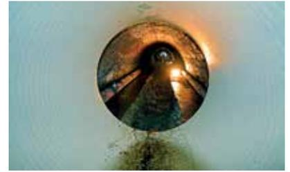
Blick aus dem neuen Rohr ins alte Bauwerk: Um Platz für das GFK-Kurzrohr DN 1624 zu schaffen, wurde das vorhandene Steinzeug-Gerinne abschnittsweise aus dem Sammler herausgestemmt. Foto: ISAS
