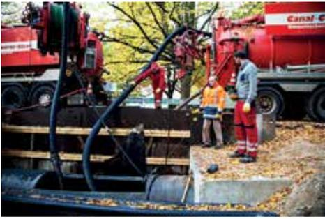
In den Baugruben wurde zunächst eine Reinigungsrevision geschaffen. Die Rohrsohle blieb erhalten, nur der Scheitel wurde geöffnet.
